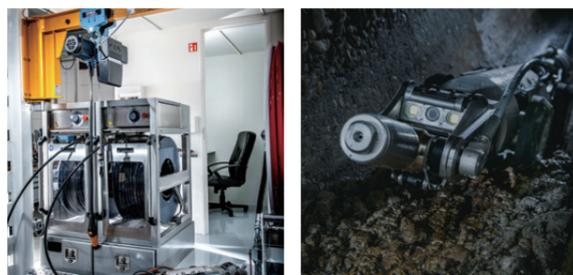
専任のオペレーターが、リアルタイムに下水道の内部をカメラで把握しながら清掃作業を行う。ノズルの付け替えにより、更生工事も可能である
