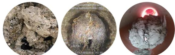
下水道管内の堆積物は、油脂、木根、セメント等があり、経年により多量化し、さらに管の劣化にもつながることから早急な清掃と更生工事が急務となっている
